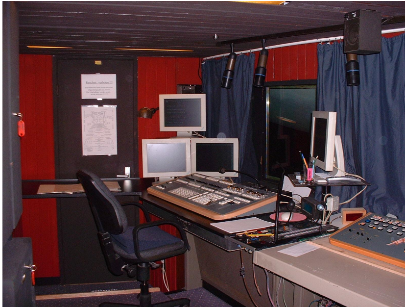
Abbildung 1.2.: Die Schaltzentrale der Beleuchtung, das Stellwerk
