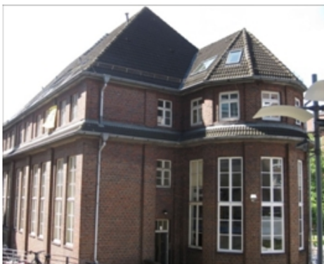
Abbildung 3: Bestandsgebäude der HAW
