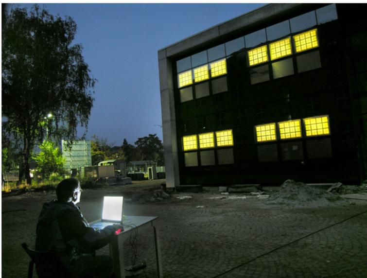
Abbildung 3: Fassade der DNA-2-Light-Installation an der Universität Saarbrücken, jedem Leuchtobjekt kann über DMX512 einer von  $(2^8)^3 = 16777216$  Farbwerten zugewiesen werden. ©Daniel Hausig
