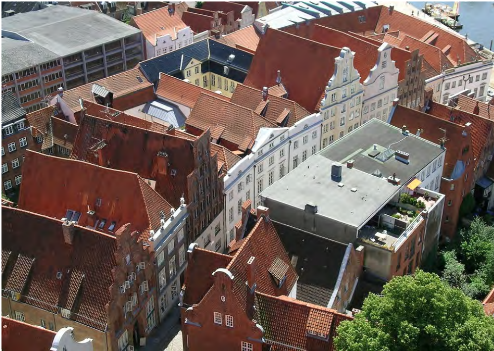
Abbildung 4.4: Blick auf die Straße Große Petersgrube in Lübeck 2
