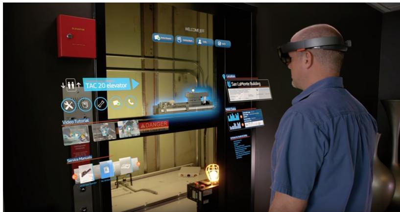
Abbildung 2.4: Nutzung der HoloLens als Unterstützung bei Fahrstuhl-Wartungsarbeiten<sup>10</sup>
